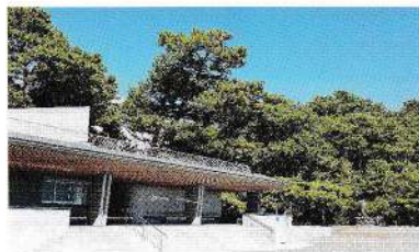
本浜に新設した本浜休憩所
