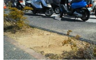
（整備以前の北口駐輪場まわり ＝平成 27 年 11 月撮影）
